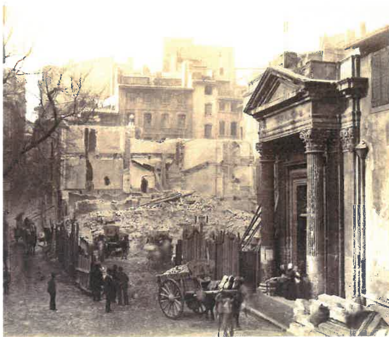
L'ÉGLISE SAINT-MARTIN ENTOURÉE PAR LES DÉCOMBRES DES IMMEUBLES DÉTRUITS POUR LE PERCEMENT DE LA RUE COLBERT.
